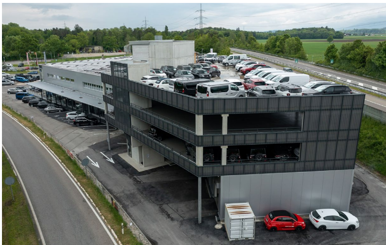
Bildunterschrift: Drei neue Parkdecks wurden realisiert. Auf der dritten, obersten Fläche dient das Deck der Nutzfahrzeugausstellung.
