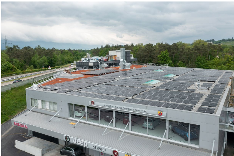
Bildunterschrift: Saubere Stromproduktion: Mit der neuen PV-Anlage wird das natürliche Sonnenlicht in ökologischen Strom umgewandelt.
